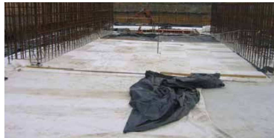
Zdjęcie 4. Zabezpieczenie płyty fundamentowej geowłókniną, styropianem i osłoną z folii
